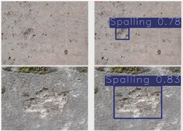
图 14 检测软件及实际壁面检测效果
