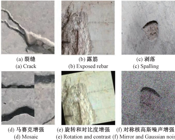
图 9 原始缺陷图像和增强缺陷图像示例图
