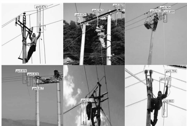
图 5 部分输电线路接地线图像目标检测结果
