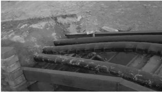
图 6 电缆直埋方法
