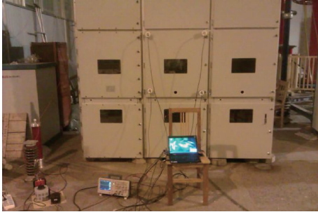
图 8 开关柜局部放电定位试验平台
