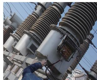
图7 CT漏电流信号获取
